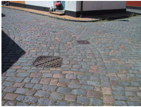
Brostensbelægning med markering af kørebane, Rønne.
