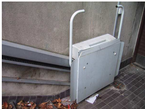
Trappelift i kælderskakt
